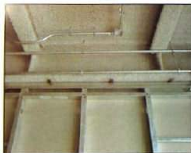
顶部滑动连接构造
